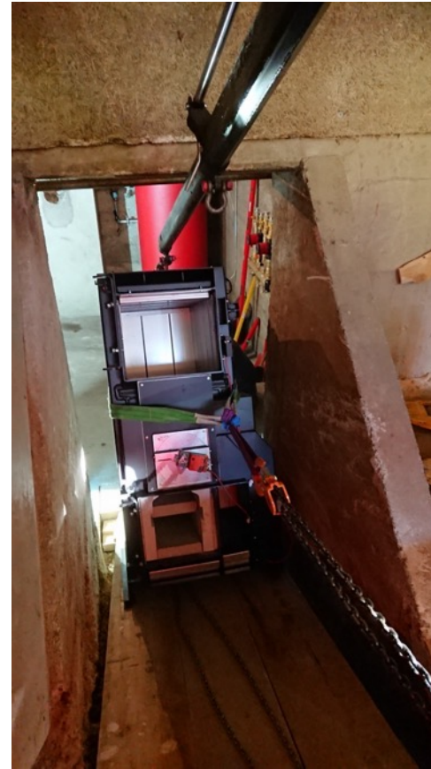
Einbringen vom neuen Kessel
